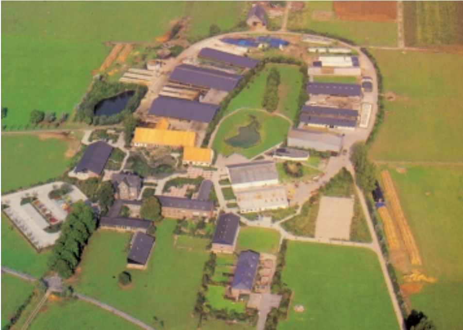
Luftaufnahme des »Riswicker Eies« 1977
